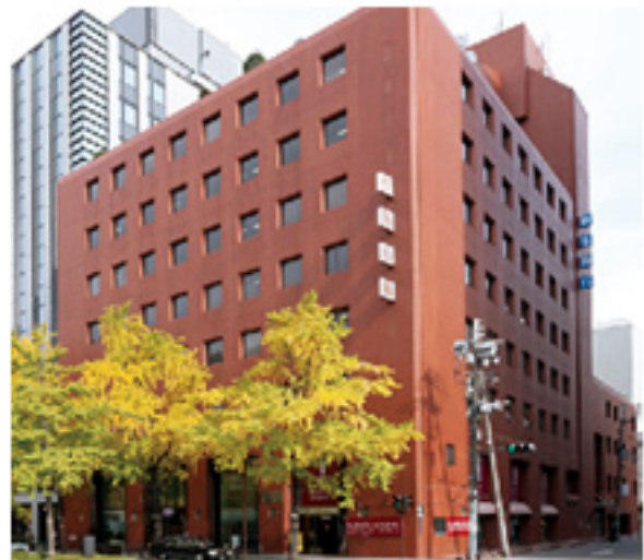
NREG 御堂筋ビル 地下 1 階
